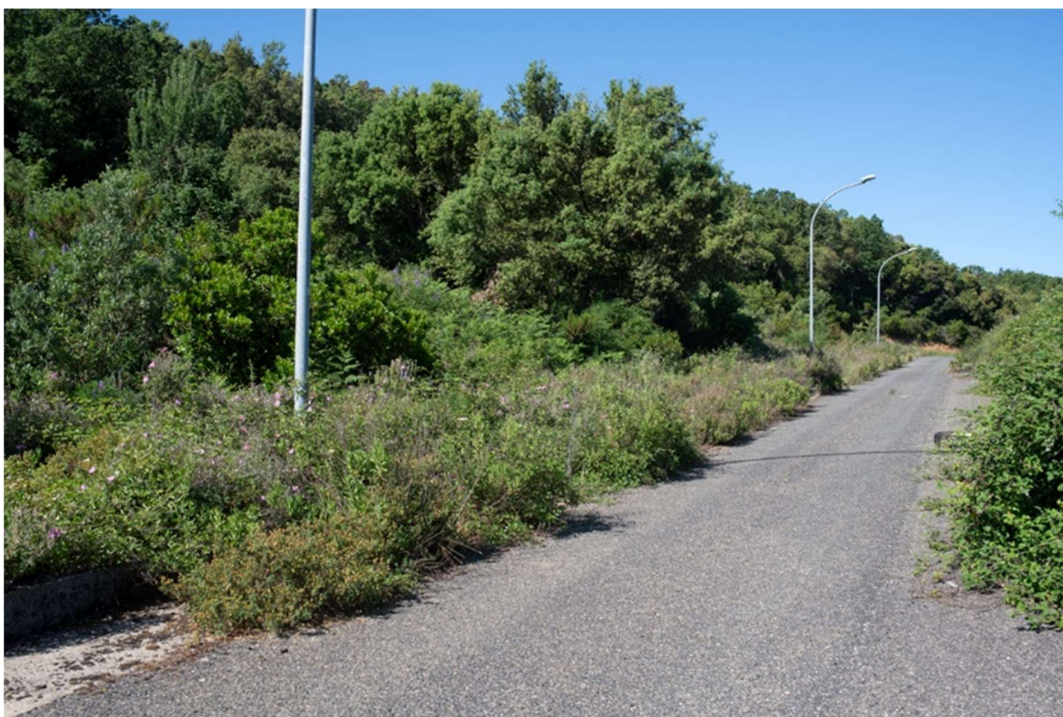
Foto 3 - Viabilità di raccordo a valle dell'area
