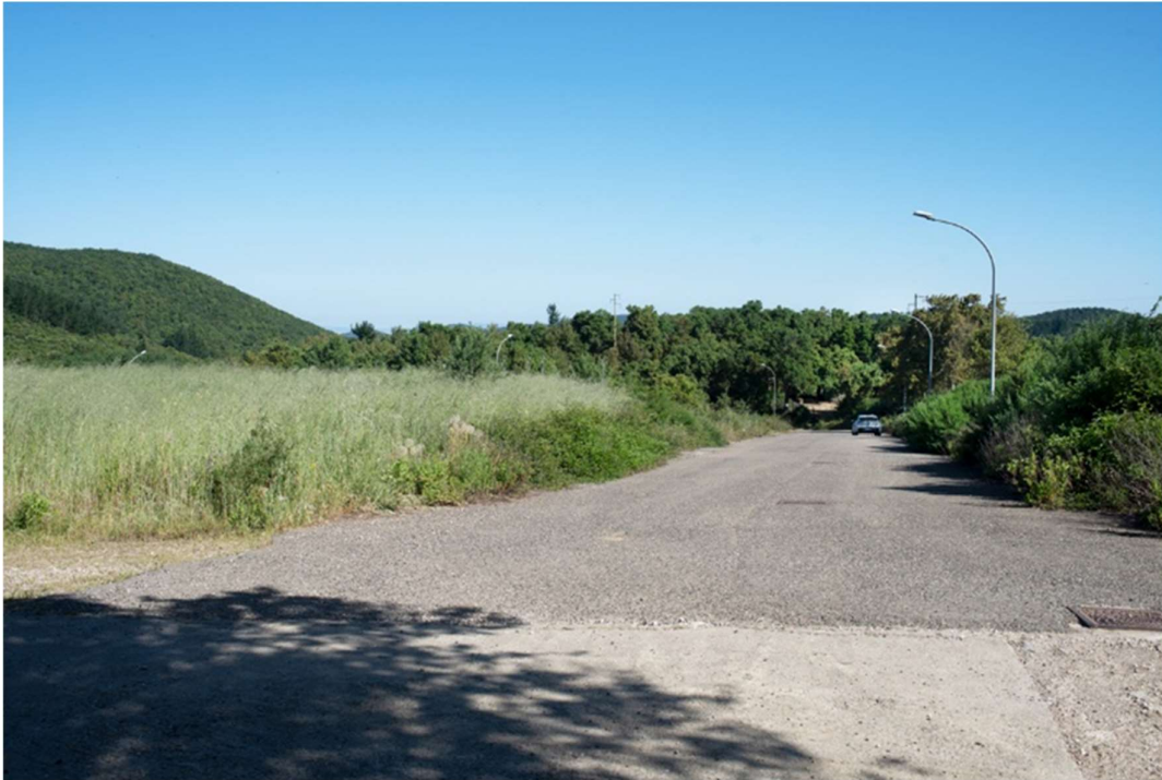
Foto 1 - Viabilità di accesso
